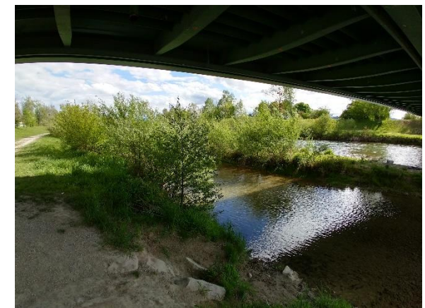
Kiesbank unter der Brücke
